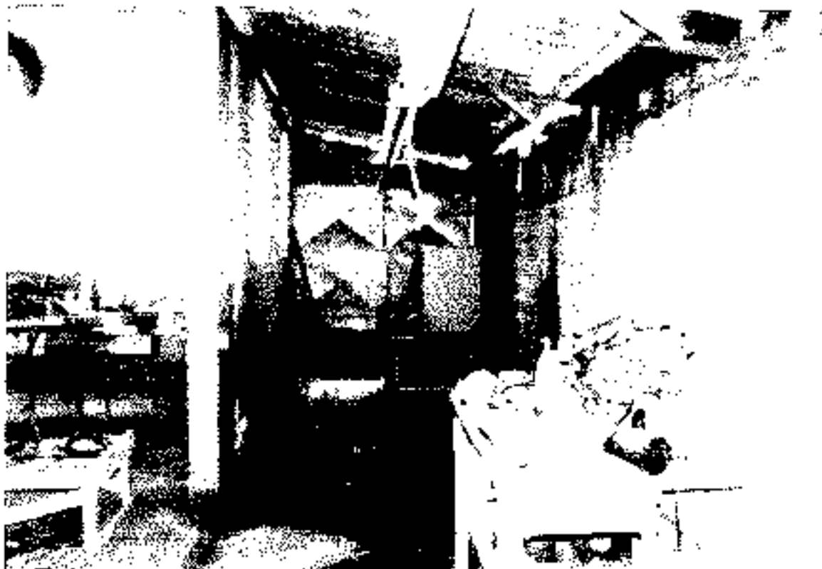
Foto 03: Vista da ampliação, onde há infiltração de água através das calhas
